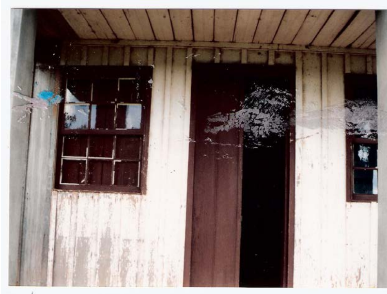
Foto 12 – Detalhes da construção em madeira.
