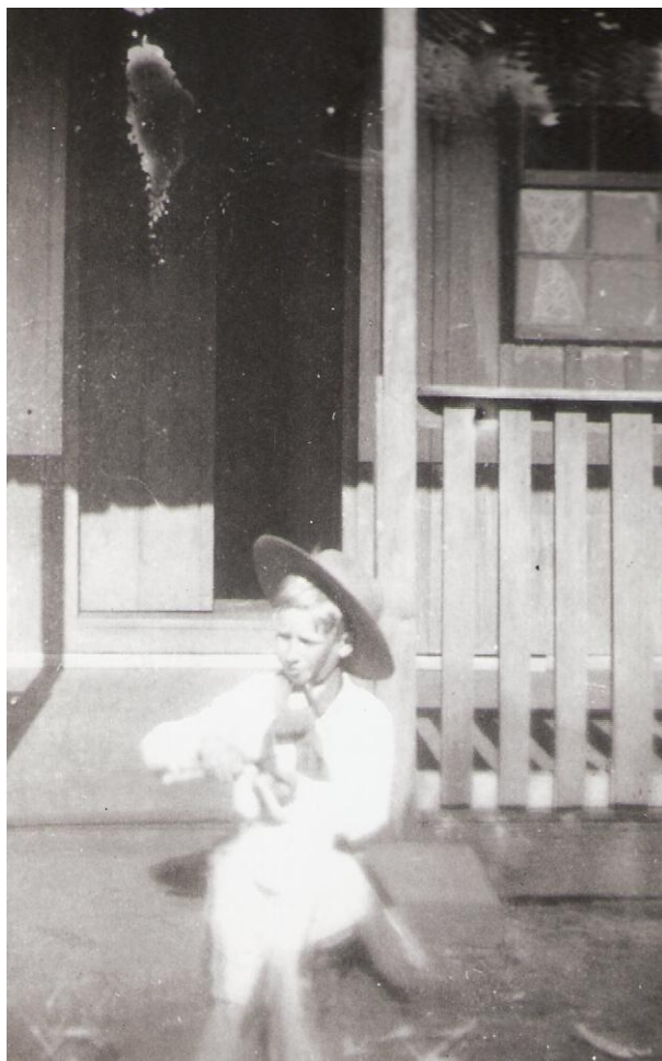
Foto 10 – Detalhe da varanda na porta da entrada da frente. Também chama-se de área.
