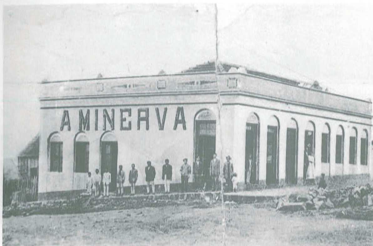
1910 - Livraria e tipografia "A Minerva". Rua Bento Gonçalves esquina Rua do Comércio (hoje Av. Brasil). No prédio estavam, também, instalados o consultório e a residência de Armando Camate, dentista prático, proprietário do imóvel. No local hoje situa-se o edifício Diogo Rocha.
