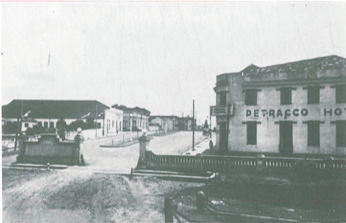
1937 - Via de acesso à viação férrea, no início das avenidas General Neto e General Canabarro. Em primeiro plano à direita, o Petracco Hotel, hoje sede da agência da Caixa Econômica Federal.
