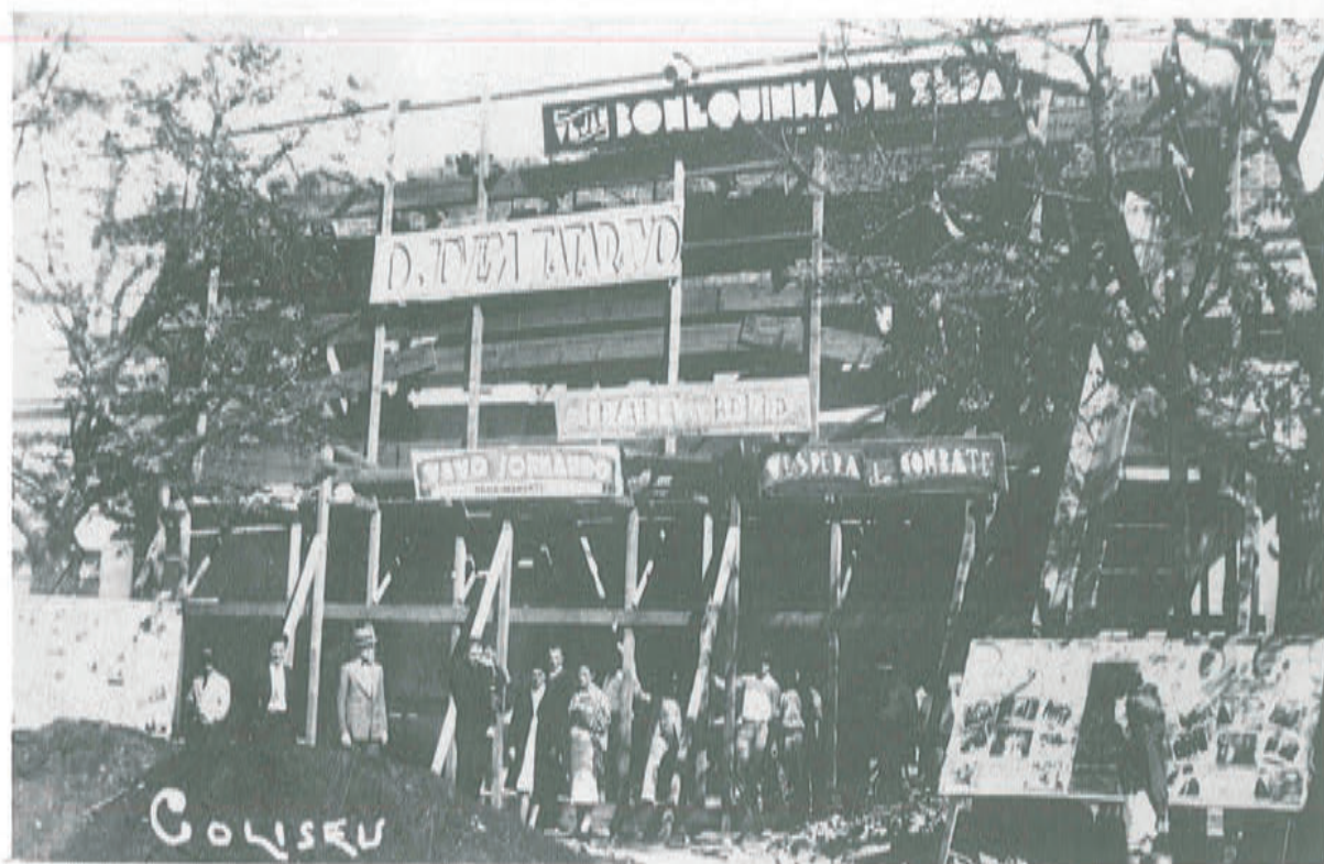
1934 - Reforma da fachada do Cine Teatro Coliseu. Em cartaz "Bonequinha de Seda". Posteriormente no local foi edificado um prédio onde funcionou o Cine Teatro Real até 1989.
