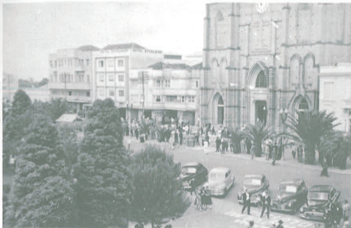
1954 - A Catedral em construção. O relógio já está funcionando. À esquerda: os prédios do "Imperial", o do "Hotel Excelsior" (no térreo o "Café Haiti" hoje "Restaurante Franz") e o do "Cine Real". Na Gal. Neto o "footing" depois da Missa das dez, os carros da época e na calçada o anúncio do jogo de futebol: "14 de Julho X Glória", de Carazinho.
