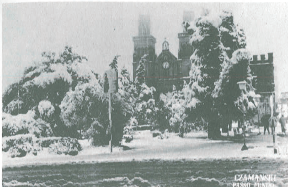
1965 - Rua Bento Gonçalves e Praça Mal. Floriano. Ao fundo, a Catedral. À direita a Torre do Transformador. O relógio aponta 12h20min, e a neve acumulada chegou a 60cm de altura em alguns locais.
