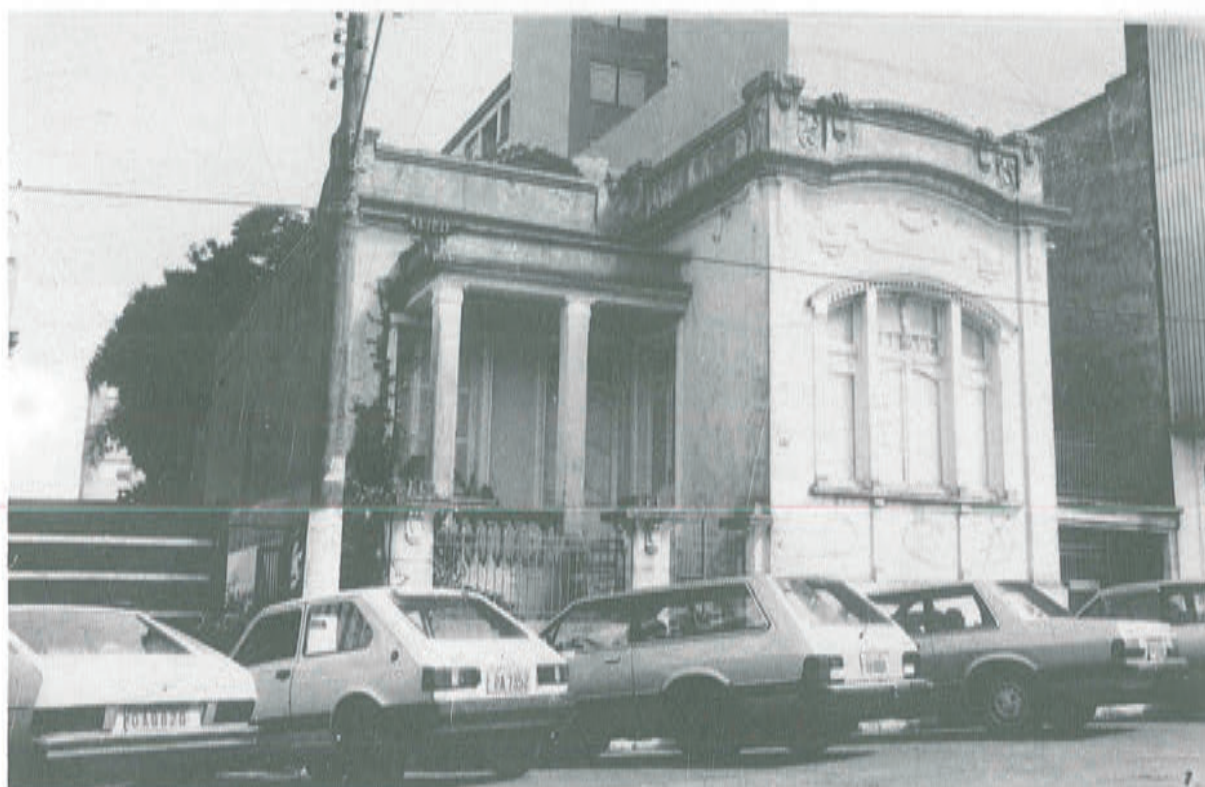
1975 - Uma das primeiras casas edificadas em Passo Fundo com o uso de argamassa de cimento. A construção data da década de 1920. Pertenceu a Eduardo Kurtz, depois ao médico Orestes Medaglia. Está preservada até hoje. Localiza-se na Rua Independência, nº 674, em frente à Praça Mal. Floriano.
