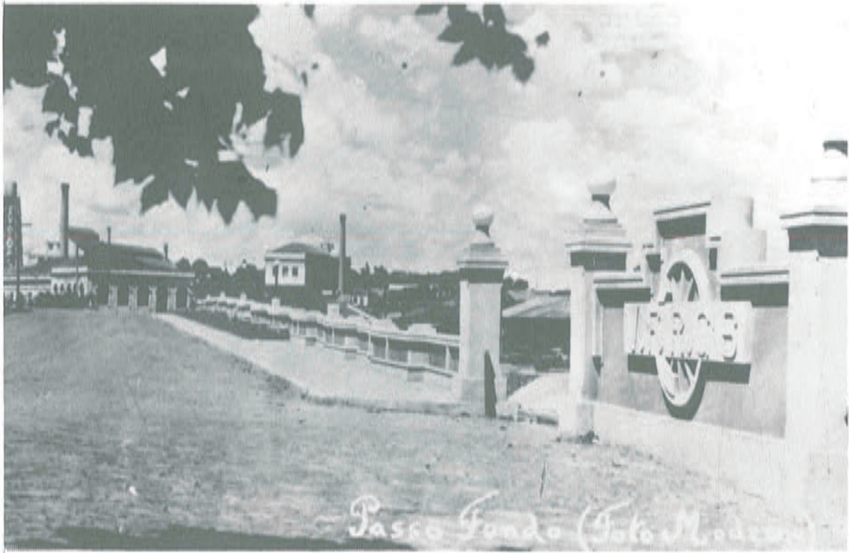
1937 - Muro e pórtico da Viação Férrea na Rua General Canabarro, construído na administração do Prefeito Dr. Nelson Ehlers.
