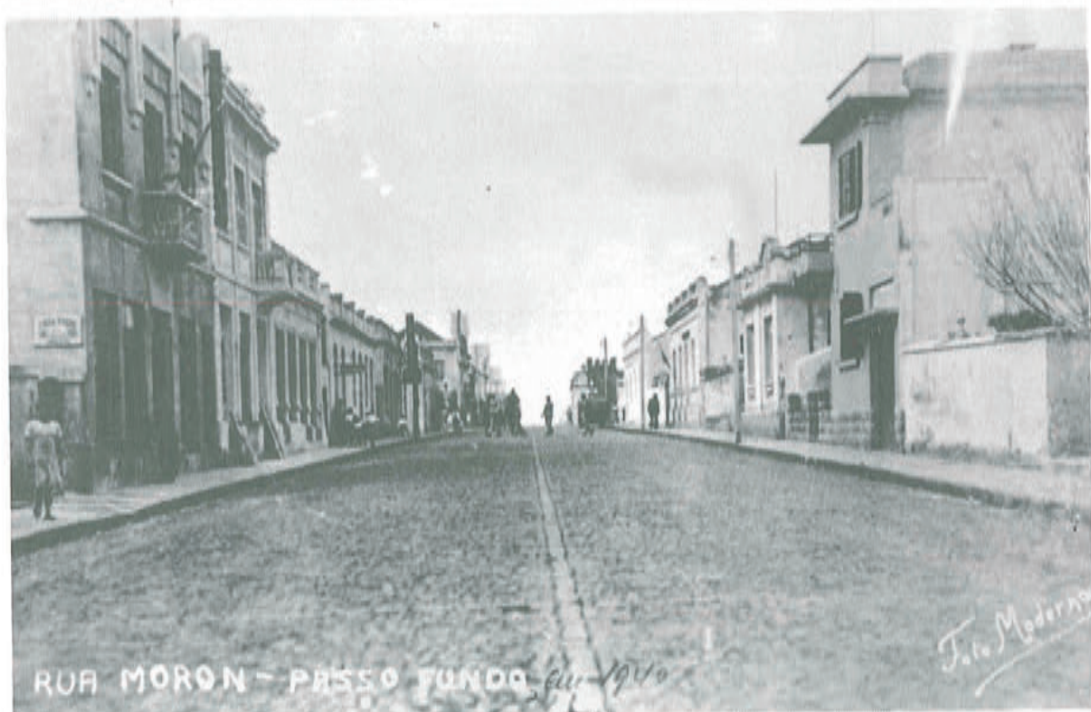
1940 - Rua Moron, perspectiva desde a esquina da Rua Coronel Chicuta. No próximo quarteirão está a praça M. Floriano. À esquerda, a "Casa Rádio" e o "Restaurante Maracanã", hoje "Empório de Tecidos".
