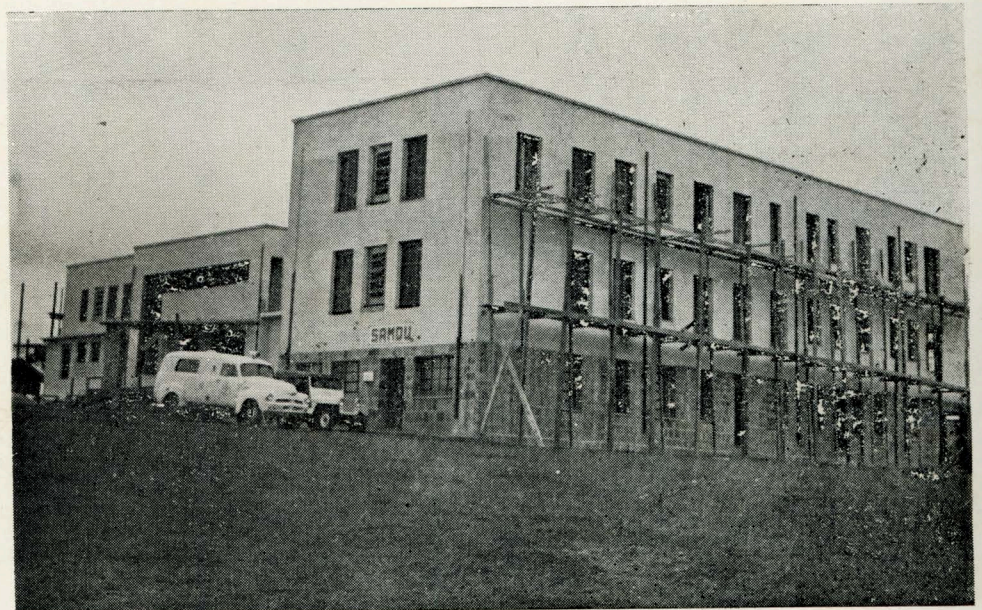
Hospital Municipal em construção. Lado Oeste.
