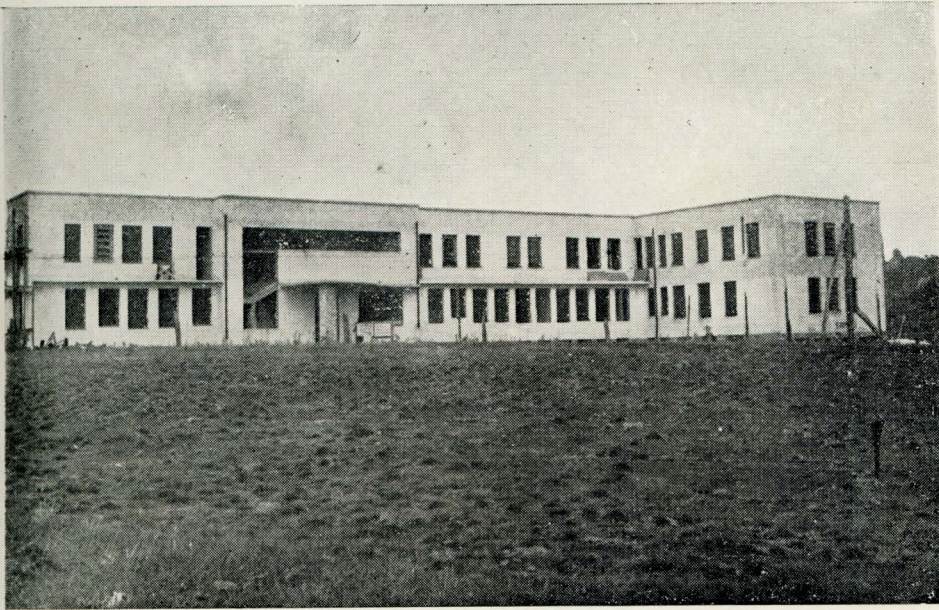
Hospital Municipal em construção. Face Central.
