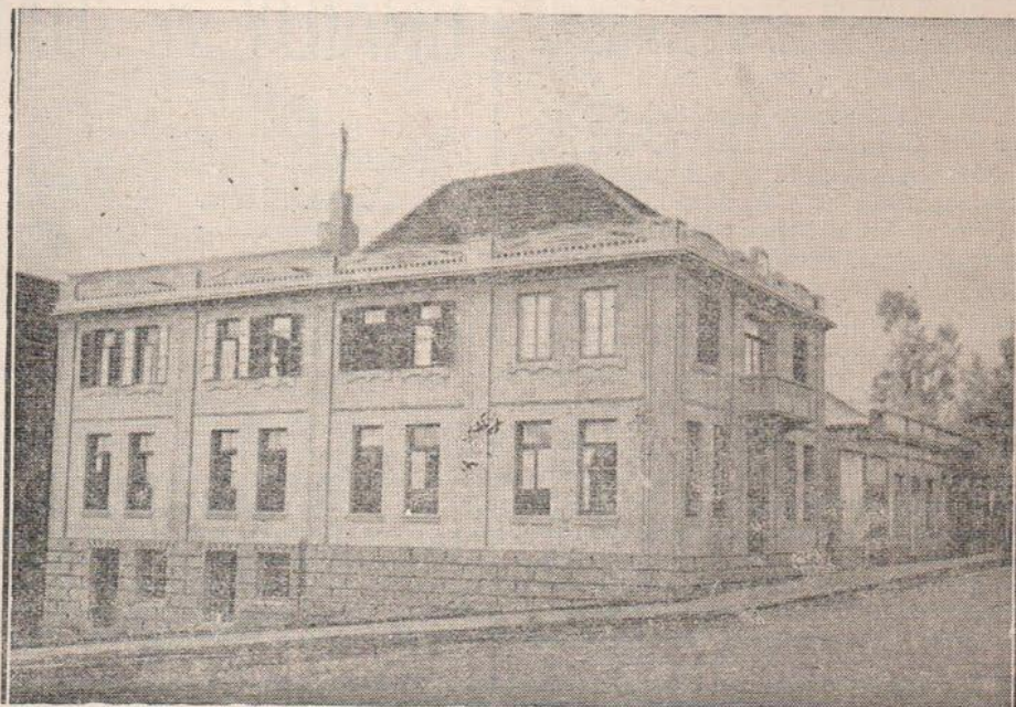
EDIFÍCIO DAS OFICINAS DA LIVRARIA SERRANA
