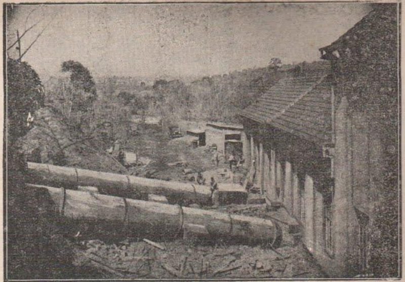
A Usina Hidro-elétrica do Potiribú
