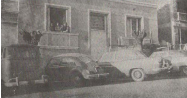
Figura 32 Casa residencial ao lado do Hotel Labarthe em demolição.
