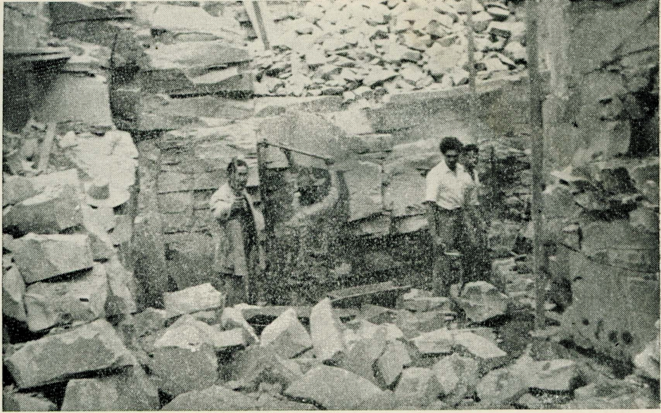
Vista dos trabalhos no porão da casa de máquinas, na Usina do rio Jacuí
