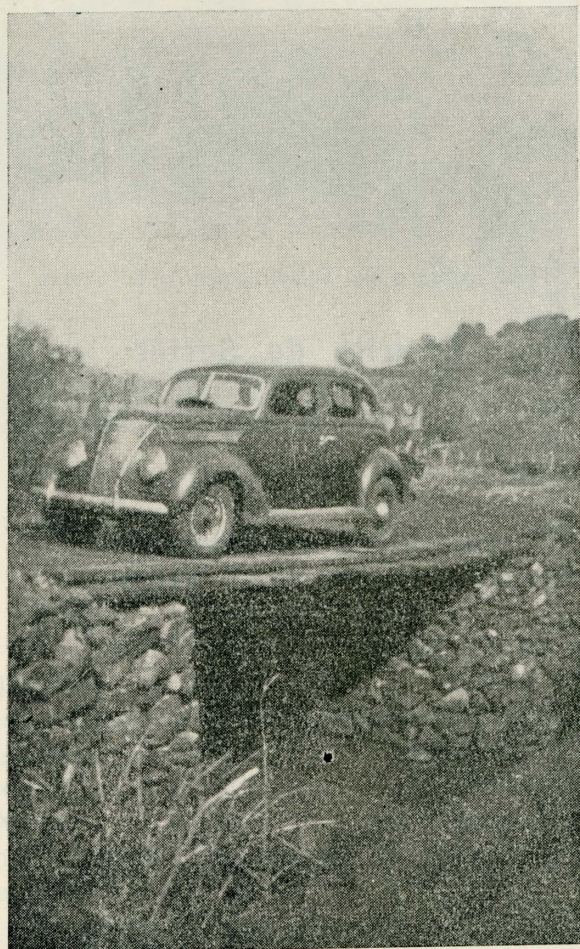
Ponte sôbre o Arroio da Anta, distrito de Tapejara
