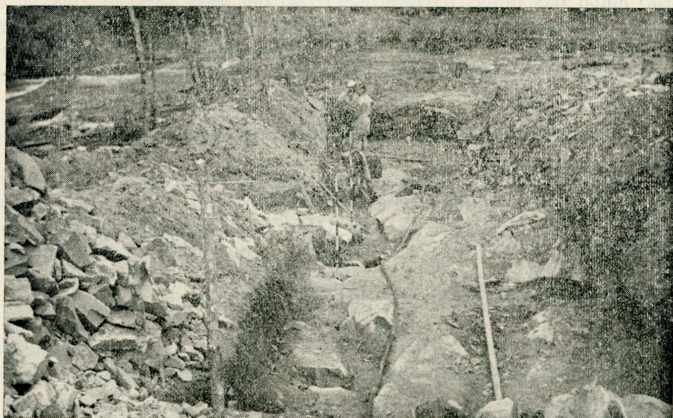
Local onde está sendo construída a barragem, no rio Jacuí
