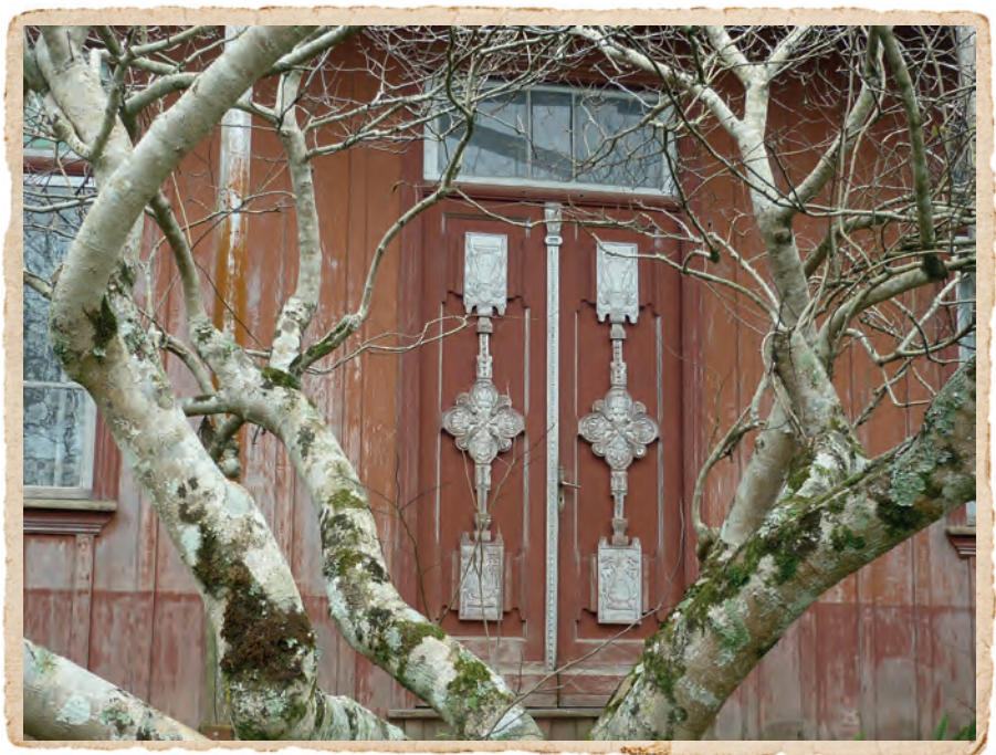
Casa Jose Tomasini - Ilópolis, 2015
