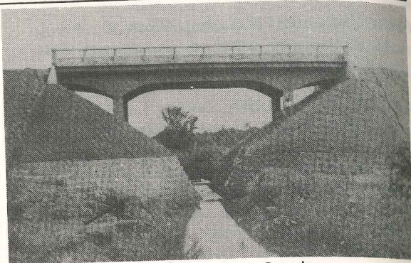
Pontilhão no arroio da Guarda
