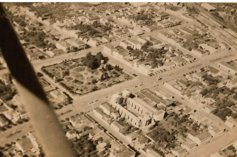
Vista aérea da área central de Passo Fundo, entre as décadas de 1940 e 1950. Acervo digital IHFP.
