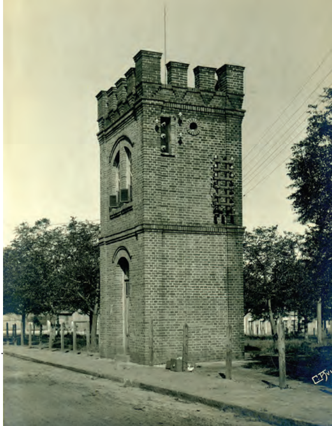
Transformador de energia elétrica da Praça Marechal Floriano, década de 1910. Photo C. D'Ávila.
