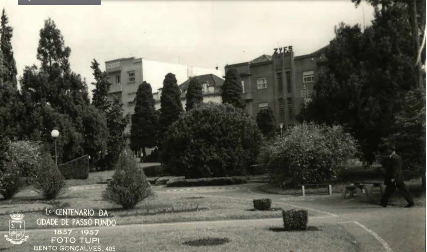
Vista da Praça Marechal Floriano, ao fundo o prédio da Rádio Passo Fundo ZYF-5 e o Edifício Scussel, ambos ainda existentes. Acervo digital IHPE.
