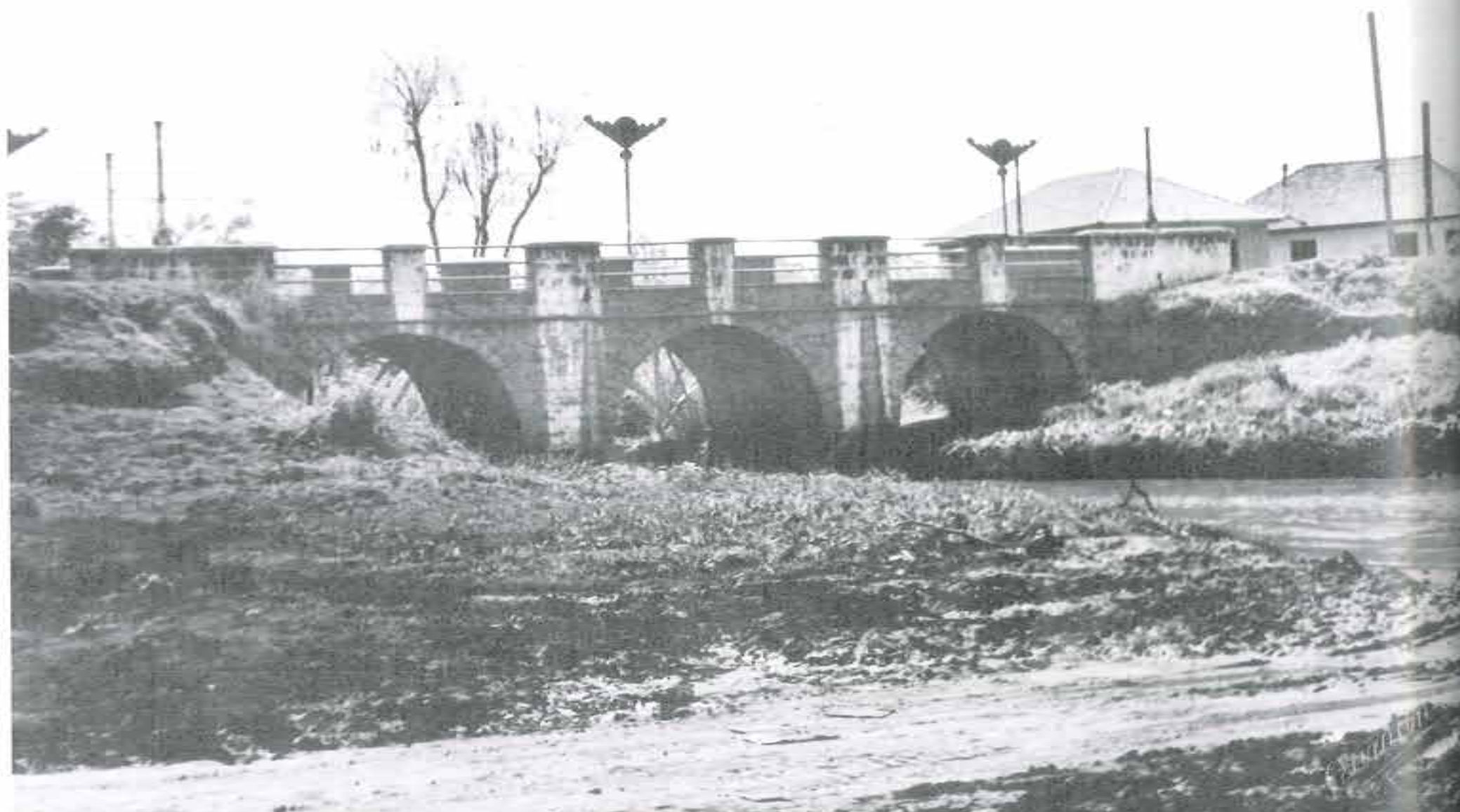
Ponte Rio Passo Fundo
