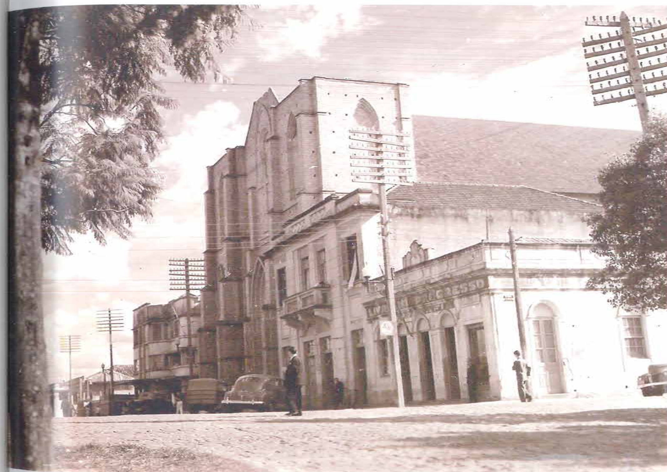
Vista da Catedral Nossa Senhora da Conceição a partir da esquina da rua Moron com a Praça Marechal Floriano
