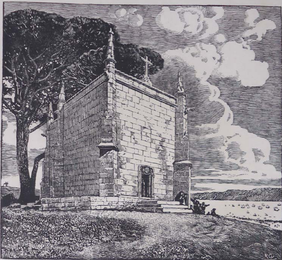
ERMIDA DO RESTELO. VISTA EXTERIOR
