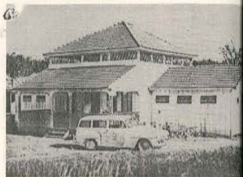
Águas do Prado: primeira casa de banho.
