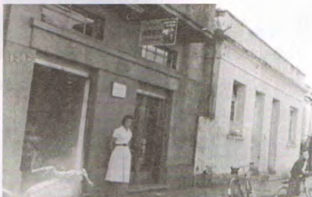
17 de agosto de 1953: fachada da loja localizada à Rua Moron, 1303
