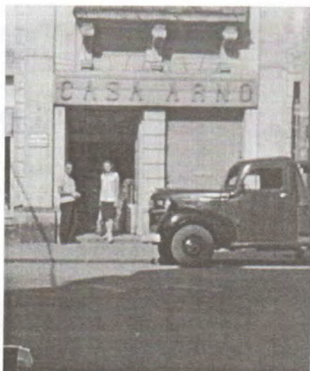
13 de fevereiro de 1963 Casa Arno, de J.J.H, já localizada no novo endereço: Rua Bento Gonçalves, 630 – Atualmente com a Cozinha Ambiente
