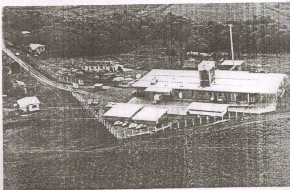
1977 - Frigorífico Mavepal: Ampliação
