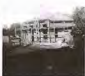
Em construção a nova Fábrica de Caramelos Neuhaus
