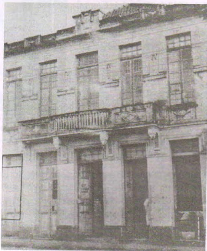
1939 – Edifício Kieling, na rua Moron. Local de funcionamento da primeira agência local do Banco do Brasil
