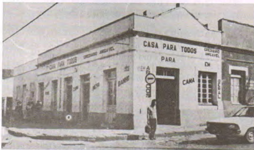
Casa construída por Adão Schell, onde ele residiu com sua família e teve também o seu negócio. Está situada na Avenida Brasil, sob os números 843 e 845, esquina da rua Teixeira Soares. Este prédio está já reformado.
