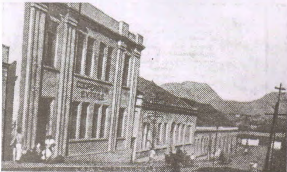
Escritórios e Armazens da Cooperativa, sede em Santa Maria
