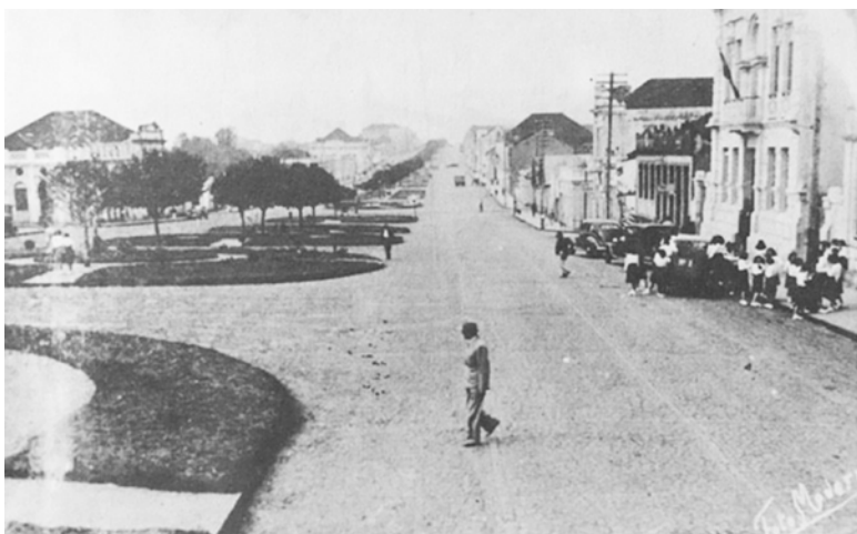
► Figura 02. Fotografia da Avenida Brasil, no trecho entre as ruas Teixeira Soares e Quinze de Novembro. Em destaque, atravessando a Avenida, o Coronel Arthur Ferreira Filho, então prefeito municipal. À direita o edifício da Prefeitura Municipal, em 1940. Autor: Foto Moderna. Fonte: Lech, Czamanski, Czamanski, 1999, p. 29.
