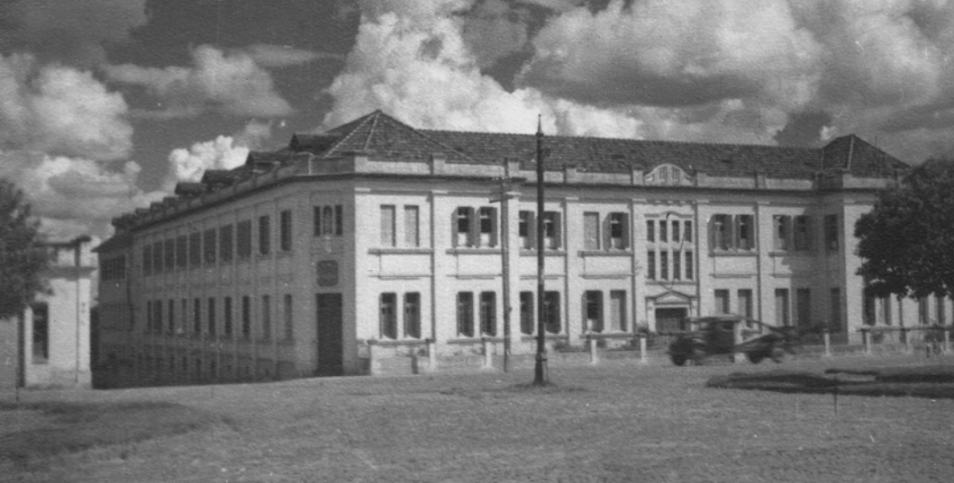
► Figura 08. Vista da Avenida Brasil e do Colégio Notre Dame, década de 1950. Projeto Passo Fundo.
