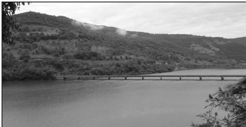
Ponte sul fiume Uruguai, tra gli stati di Rio Grande do Sul e Santa Catarina.
