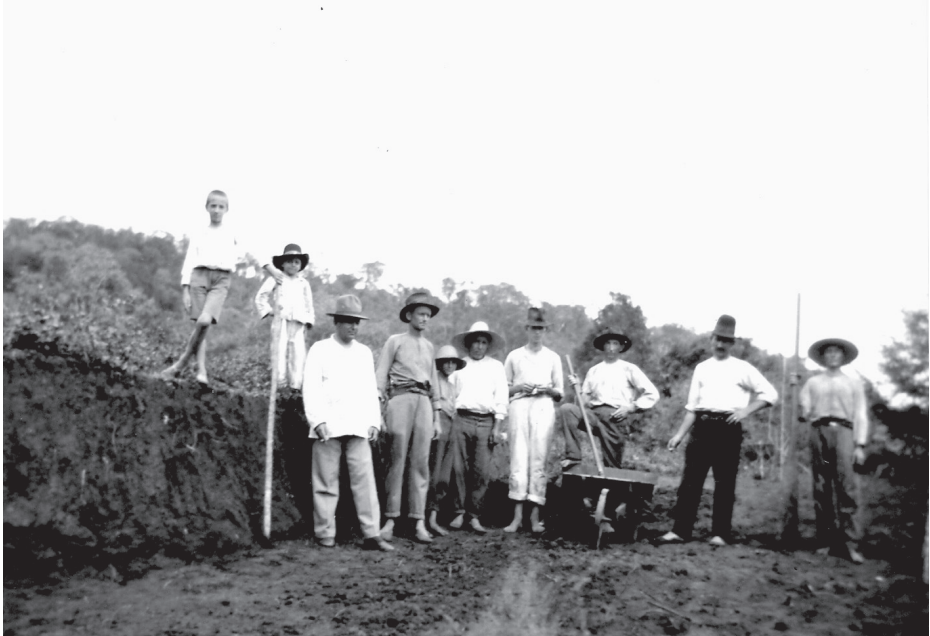
Da esquerda para a direita: Aloisio Leite (filho do saudoso médico Dr. Arthur Leite, Jorge Berthier (filho de Alberto Berthier), Alberto Berthier e demais operários em construção de obra.
