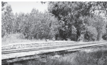
A antiga instalação da viação férrea foi totalmente demolida, restando somente o piso de concreto da plataforma de embarque-desembarque.
