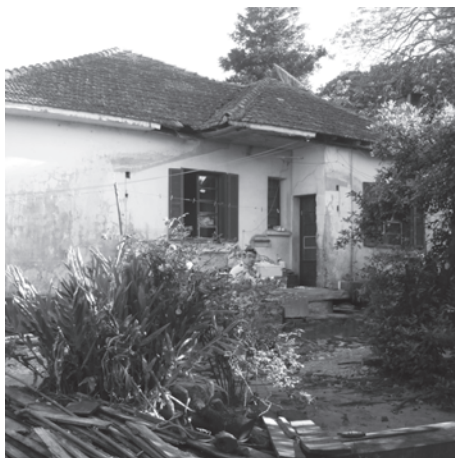
A casa do poço foi demolida
