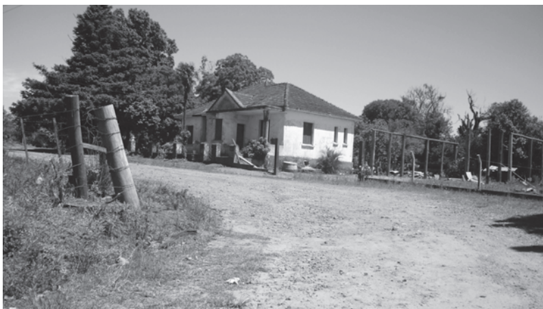
A casa já numa situação de abandono da forma original, a caminho de casa de granja
