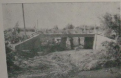
Ponte de concreto armada construída na Rua Uruguai, sobre o Rio Passo Fundo.
