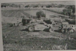
Fase da construção da ponte na Rua Uruguai, com retificação do leito do Rio Passo Fundo.
