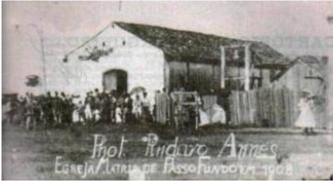
Figura 2 A primeira Igreja Matriz localizada na Av. Gal. Neto e demolida no início do século XX.
