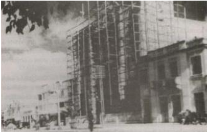
Figura 9 A Catedral em construção.
