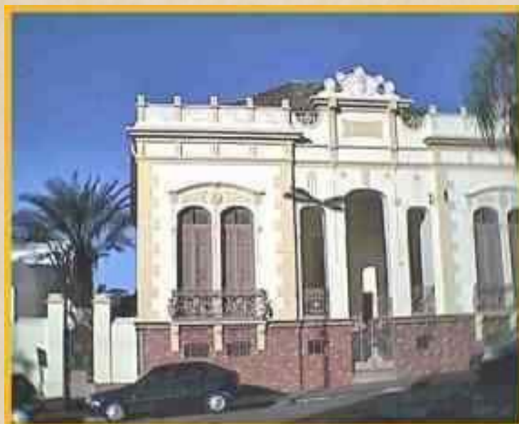
Residência do Sr. Candido Nascimento e Silva (próxima ao Museu Erico V.)
