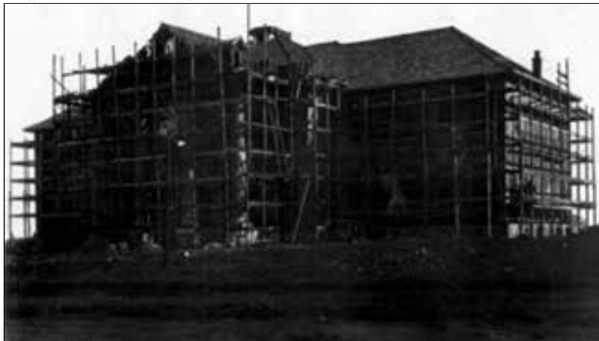
IE - Instituto Gymnasial -1922 – Prédios Texas em construção
