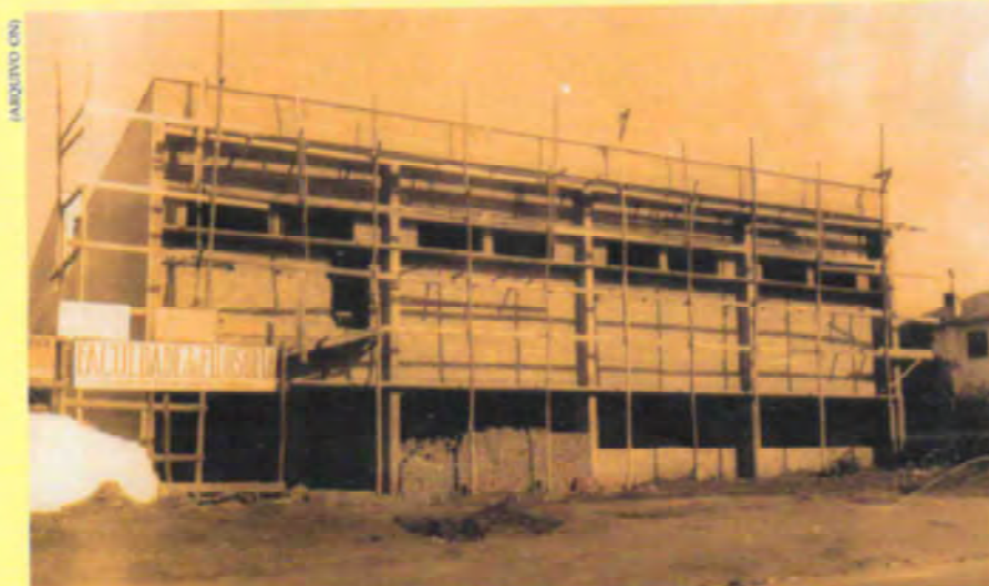
Construção do prédio da Faculdade de Filosofia
