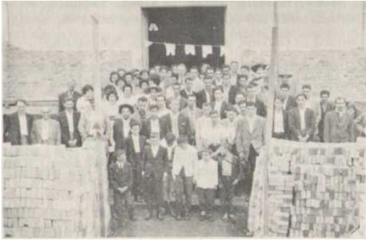
Figura 114 Capela nova em construção — Capela Nossa Senhora da Luz - Esteira.
