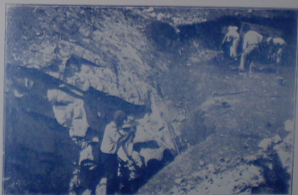
Fig. 16 — Vista da pedreira municipal
