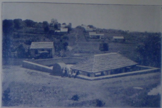
Fig. 5 — Vista externa do Chafariz, tirada da rua Uruguay
