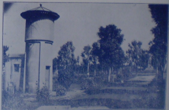
Fig. 8 — Caixa d'agua e vista parcial da Praça Tamandaré
