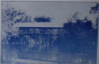
Fig. 2 — Vista lateral da ponte do Rio da Gloria
