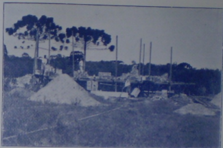
Fig. 9 — O Matadouro Municipal em construção
