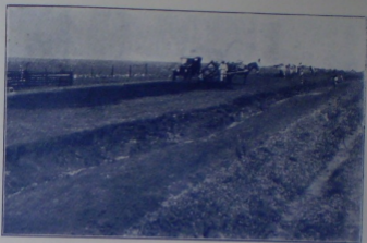
Fig. 13 — Turma em trabalhos na estrada para a Colonia d. Ernestina
