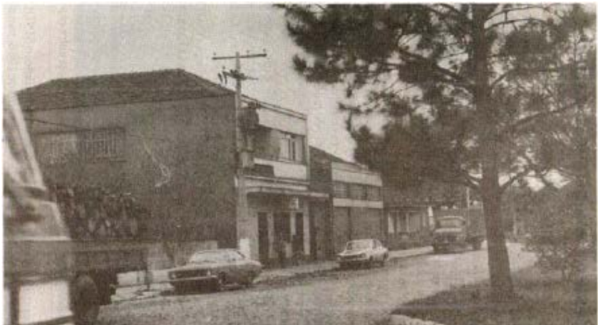
Figura 38 Antigas instalações da empresa Di Domênico na Av. Presidente Vargas - 1963
