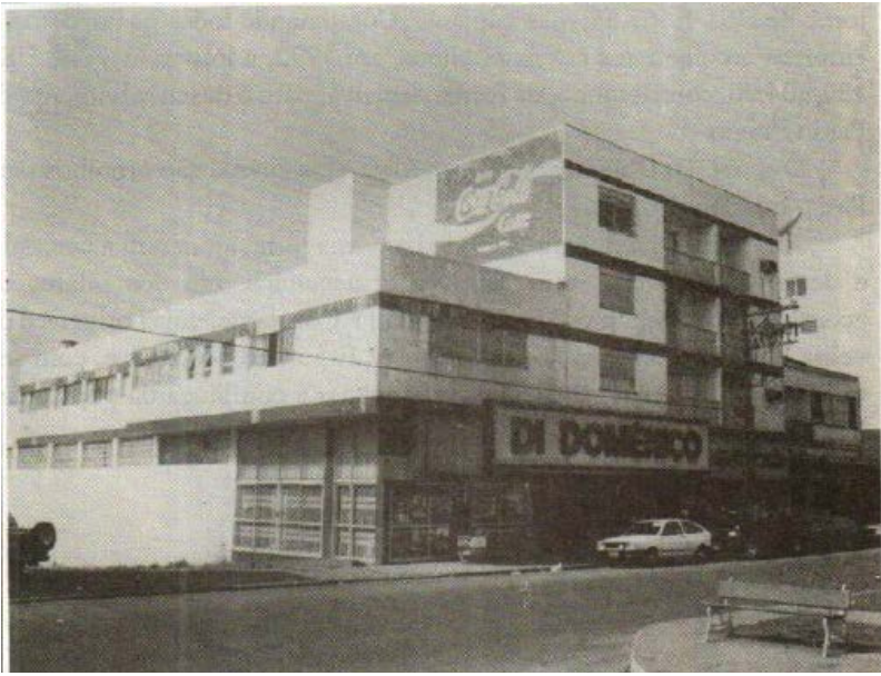
Figura 37 As modernas instalações da Empresa Di-Domênico, na Avenida Presidente Vargas - 1992
