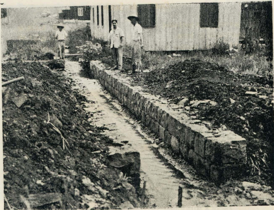
PONTILHÃO, À RUA 7 DE SETEMBRO
