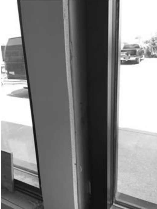
Figura 4 – vista do isolamento acústico e térmico.
