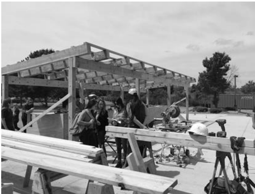
Figura 5 – construção do bar na parte externa.
