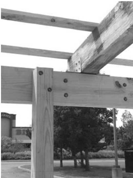
Figura 7 – amarração da estrutura wood Frame.
