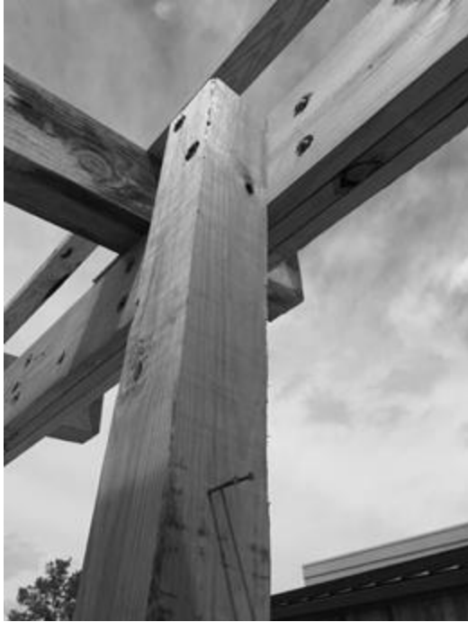
Figura 6 – detalhamento do telhado em construção.
