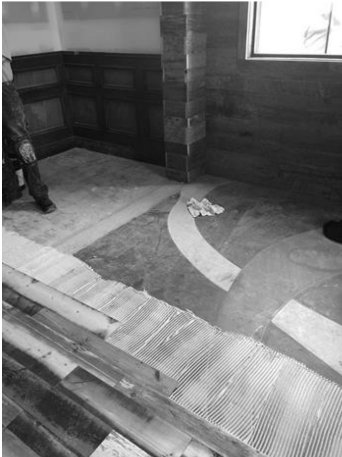
Figura 3 – colocação do piso.
