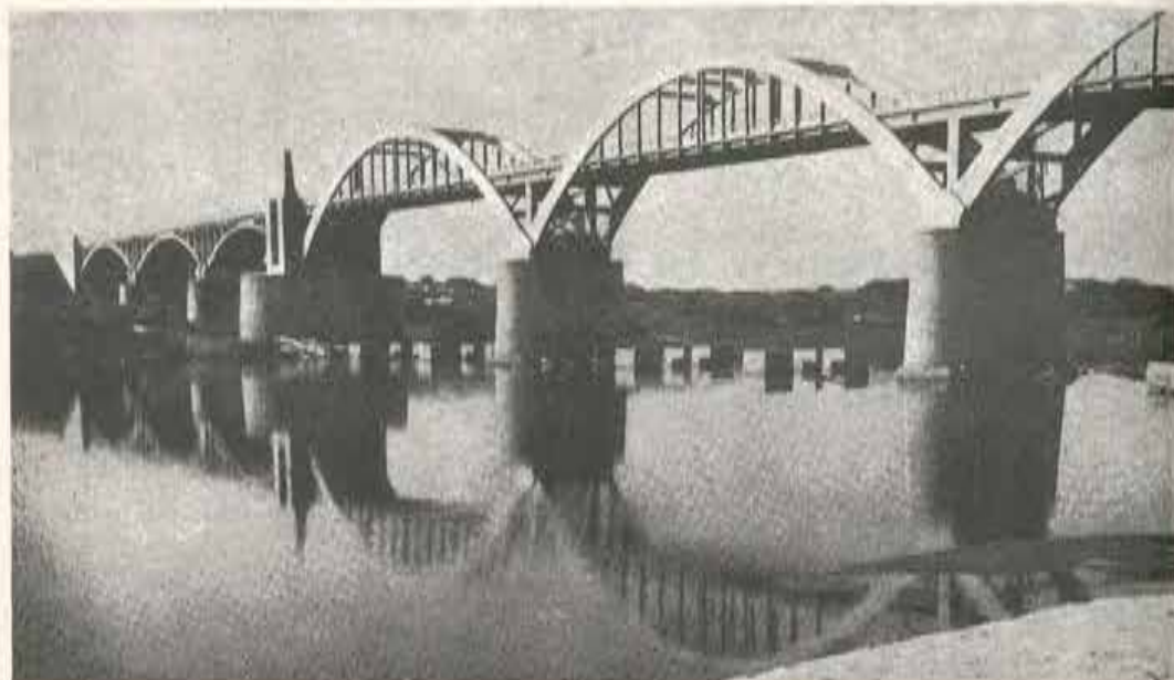
Ponte rodoviária sobre o Ibicuí entre Alegrete e São Francisco de Assis, construída em 1946. Vão de 478 metros.
