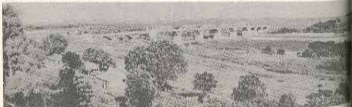
Outra vista da ponte sobre o Ibicuí
