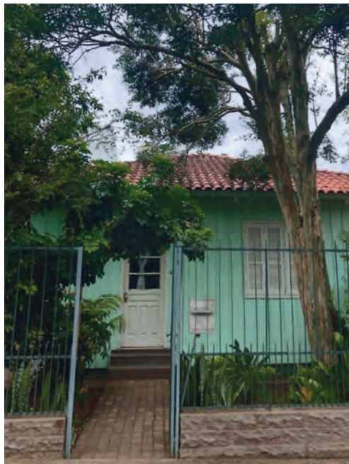
Casa que foi feita para morar quando casamos, com Heitor participando de sua construção. Guaporé.
