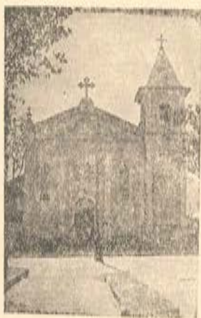
A velha e histórica Igreja Matriz de Nossa Senhora da Conceição, à Praça Tamandaré, a mais antiga igreja de Passo Fundo, atualmente tendo passado por reforma.
