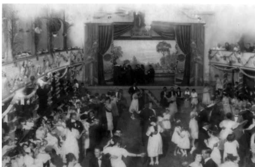
Interior do cinema Coliseu
