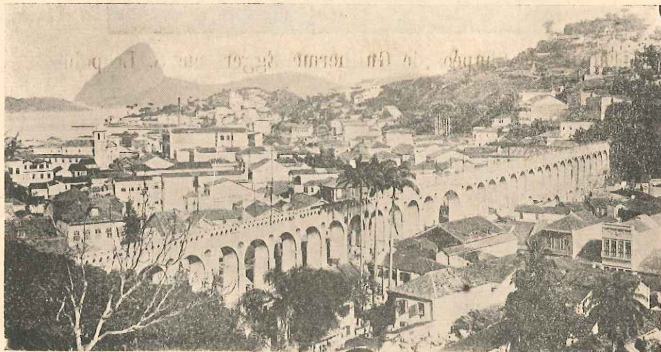
Viaducto Rio de Janeiro.
