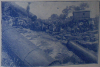
MONTAGEM DO CONDUCTO 150 HP.
