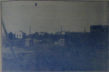
A PONTE DE ALVENARIA DO RIO PASSO FUNDO; VÊ-SE, TAMBÉM O ATERRO PARA NIVELLAMENTO DA RUA CAPITÃO JOVINO
