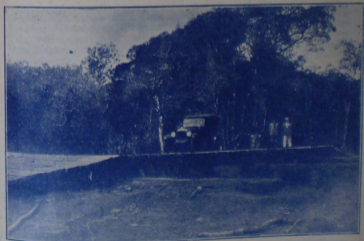
PONTE DO RIO DO PEIXE, CONSTRUÍDA PELOS SRS. A. OLIVEIRA E J. ELY, TENDO A INTENDENCIA AUXILIADO COM 1:000$000.
