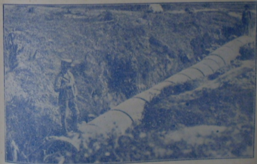
A CANALIZAÇÃO DE UM CURSO D'ÁGUA NA RUA URUGUAY, COM TUBOS DE 90 CMS. DE DIÂMETRO, ANTES DO ATERRO.
