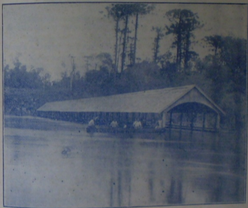
VISTA DA PONTE WEIDLICH, POR OCASIÃO DE UMA DAS GRANDES ENCHENTES
