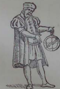
Fig. 12 — Posagem do sol no astrolábio. Cópia do Regimento de navegação de Pedro de Medina, Sevilha, 1582.
