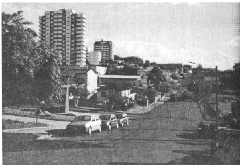
Figura 26 Rua Uruguai recebendo camada asfáltica em direção ao bairro Boqueirão. Ano 2003.
