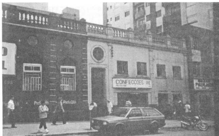
Figura 6 O prédio n° 687, na Av. Brasil foi residência de Gabriel Bastos, mandatário da cidade no início do século XX. Com exceção da porta, ao centro, as janelas do prédio já sofreram transformações descaracterizando o estilo arquitetônico.
