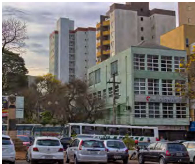
Vista do mesmo edifício, 2015.
