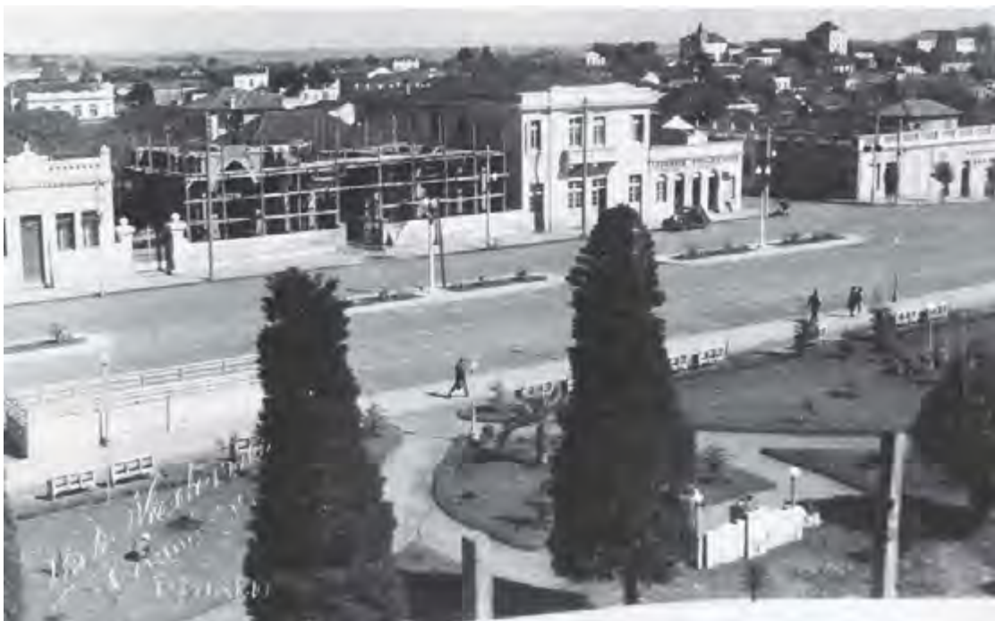
Av. General Neto. Construção da Catedral. Foto Czamansky.
