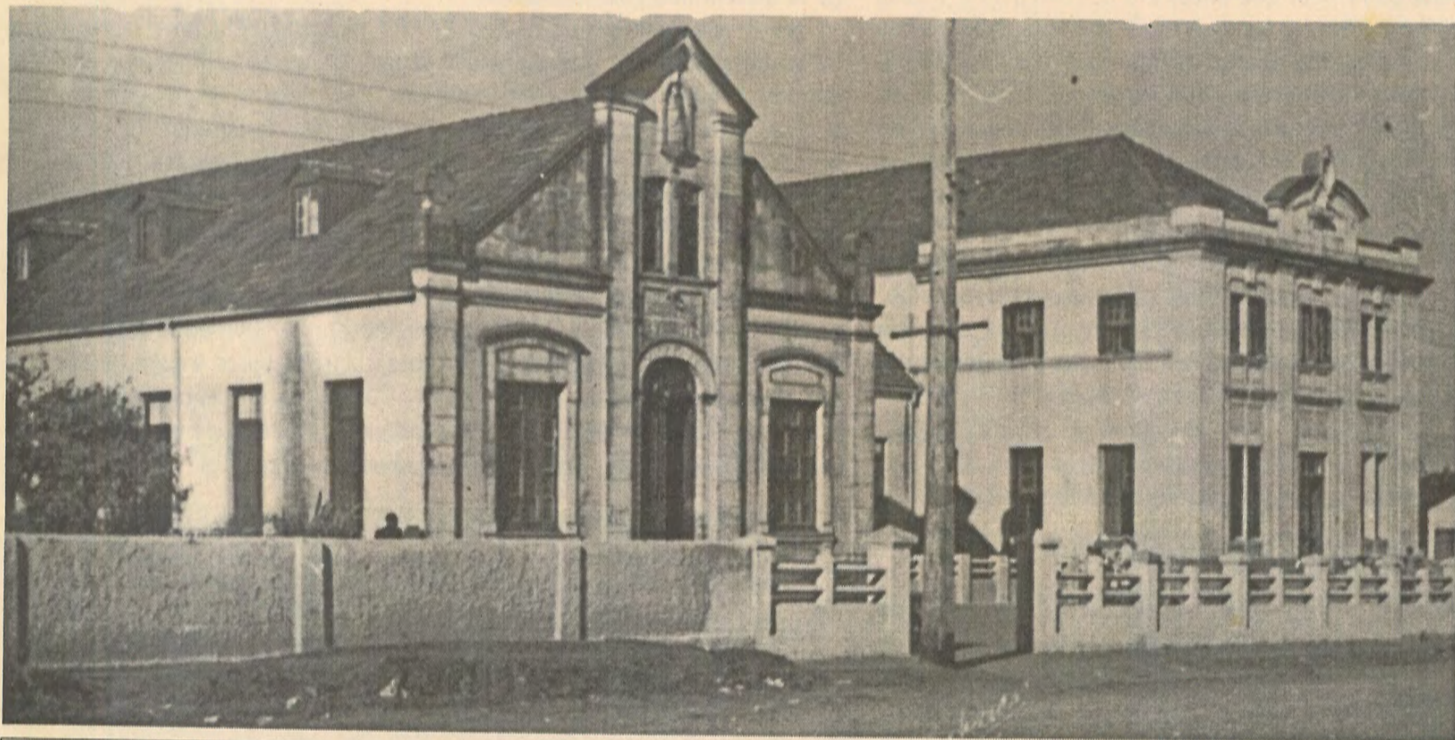
Prédio do HSVP em 1930.
