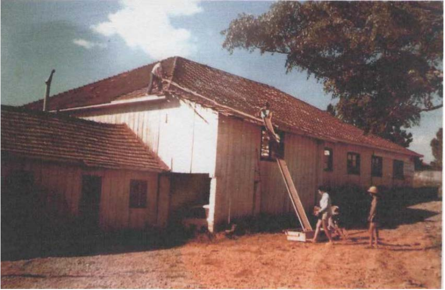
Figura 55 O velho Galpão do CTG Lalau Miranda, sendo demolido. Welci Nascimento - 1980
