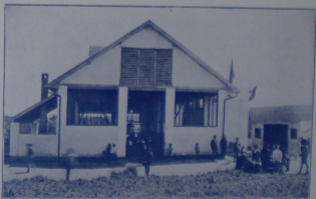
Vista lateral do Matadouro Municipal.
