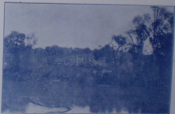
Ponte do rio Turvo, recebida em 5 de Junho, com 46 m x 5 m.
