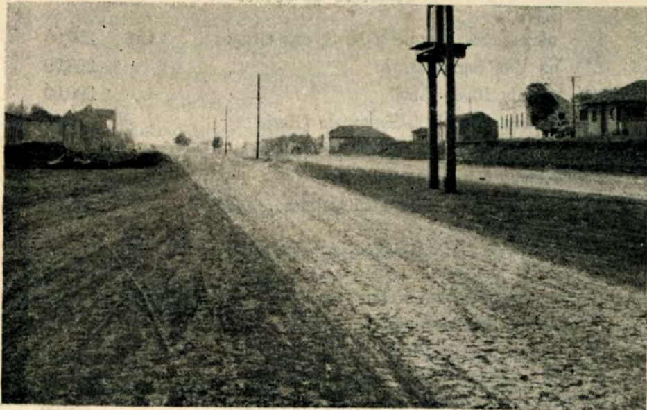
SERVIÇO DE TERRAPLANAGEM, NO BOQUEIRÃO
