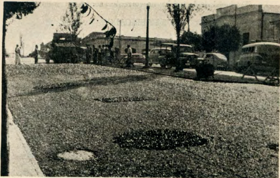
ASFALTAMENTO DA AVENIDA GENERAL NETO — INICIADO A 15-5-51
