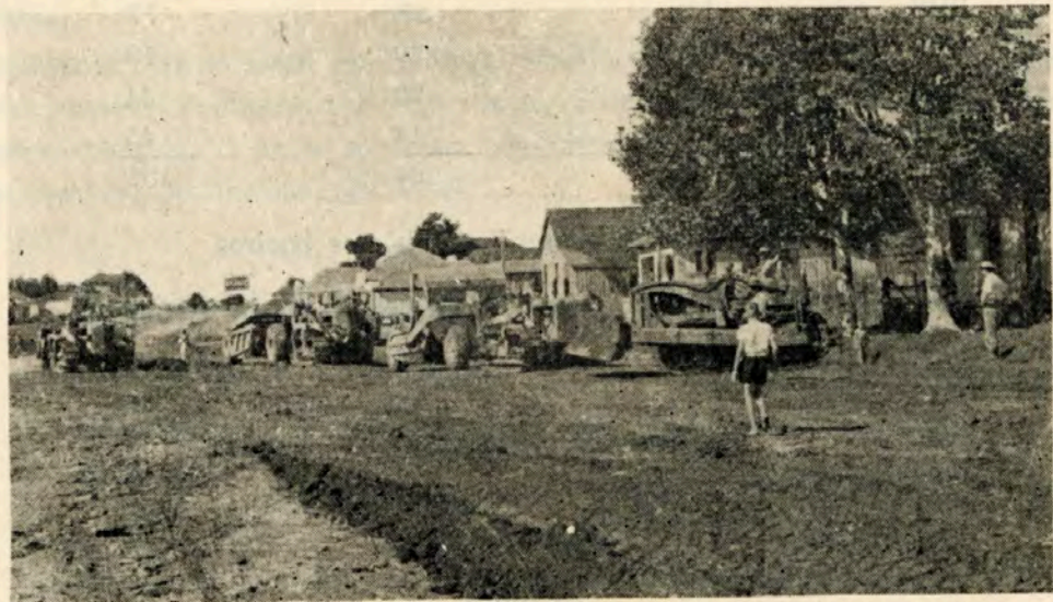
SERVIÇO DE TERRAPLANAGEM NO BOQUEIRÃO
