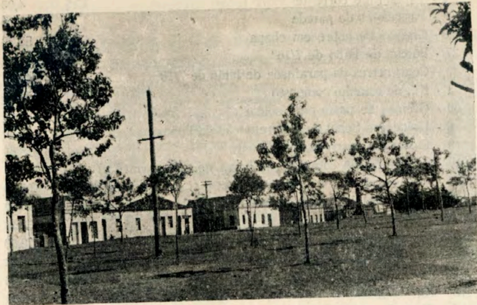
Vista de um trecho da linha de alta tensão para o transformador n.º 17, Av. Brasil — Boqueirão
