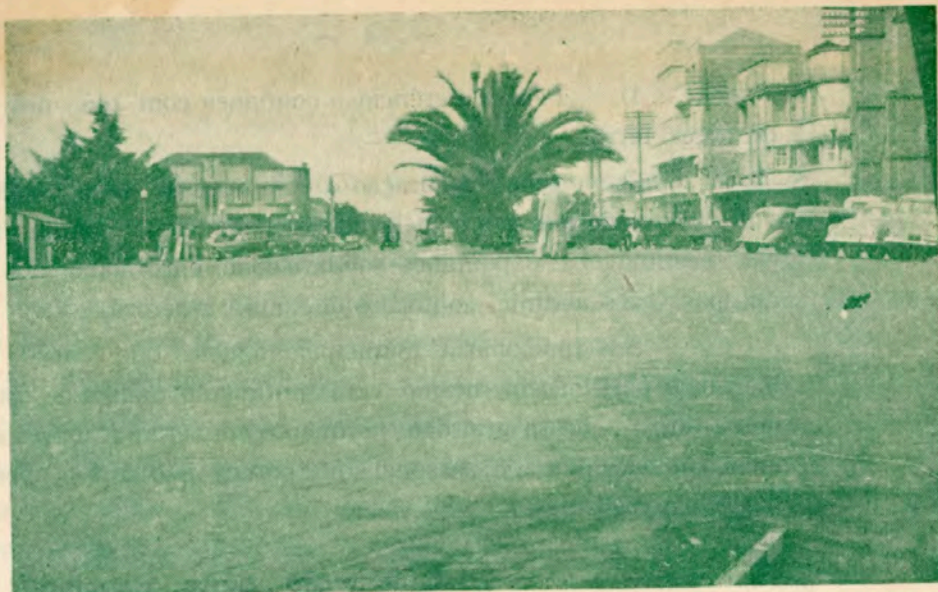
ASFALTO, AO FINAL, AV. GAL. NETO
