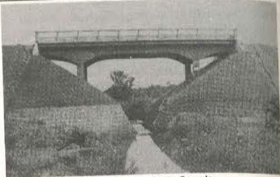
Pontilhão no arroio da Guarda
