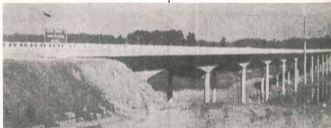
A chamada Ponte do Aço , sobre o arroio dos Ratos, presta grandes serviços à Aços Finos Piratini
