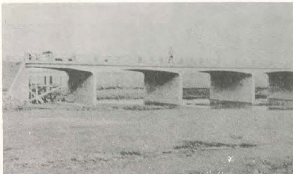
Ponte em laje maciça sobre o arroio do Salso 2 , na rodovia federal BR/37
