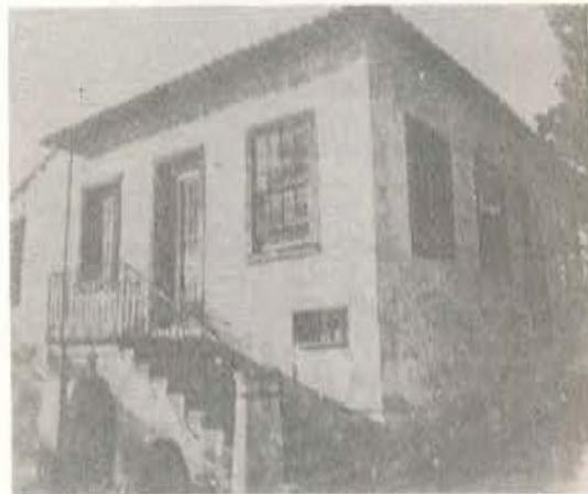
Cidade de Porto Alegre : solar de Lopo Gonçalves Bastos, hoje totalmente restaurado e transformado em museu
